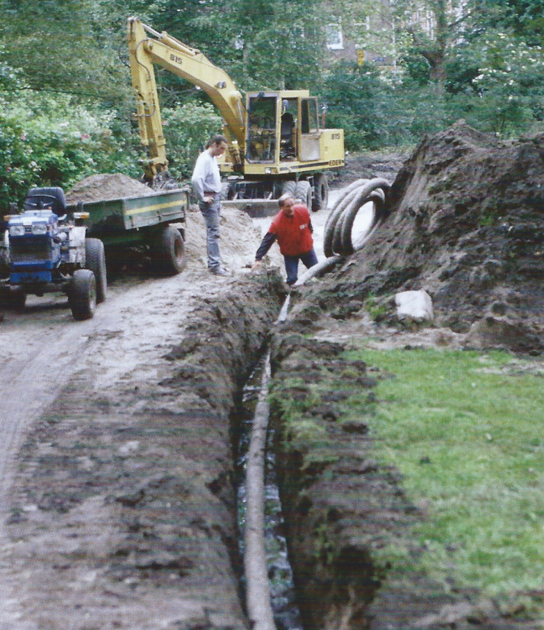
Sarphatipark: hierboven: drainage aanleg langs pad (groot onderhoud 1994) rechtsboven: werken met klein materieel (1994) rechtsonder: oude populieren die in 1994 gehandhaafd zijn (juni 2016)
